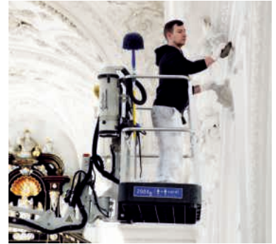
Fachmännische Innenreinigung in schwindelerregender Höhe.
